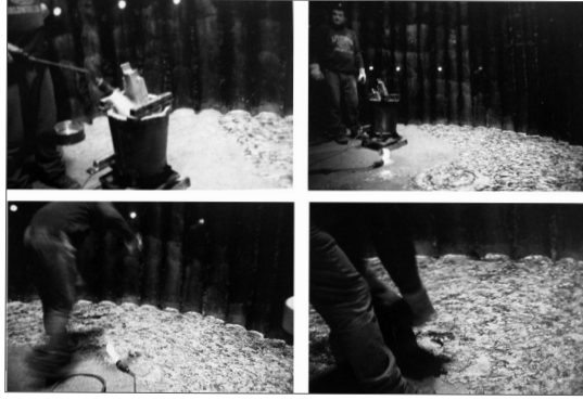
Görsel 5. Eritilmiş Kurşun Kaplama Zemin Yapımı, Baglione C.,2007
